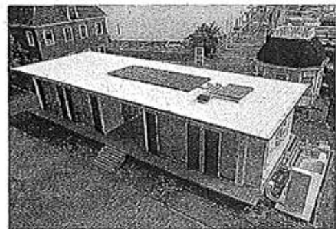
HTB内に開設したスマートハウスの屋根には断熱塗料を導入している
